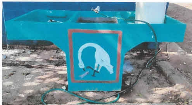
Foto 7: Instalación de pila de dos lavaderos
