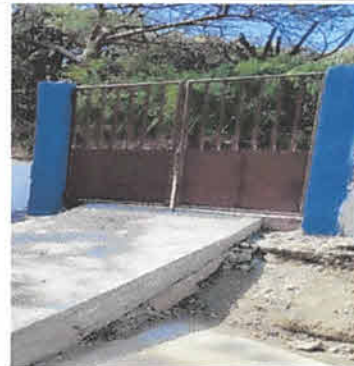
Foto 4: Restauración de area de ingreso.
