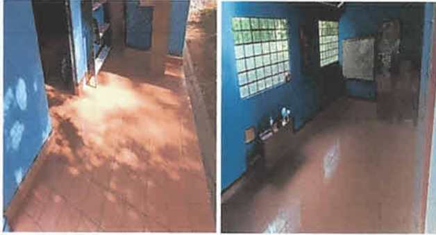
Foto1: Mejora de base de piso actual e instalación de piso ceramico.
