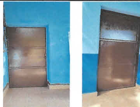
Foto 6: Restauracion de puertas de aulas
