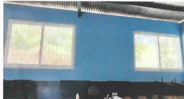
Foto 8: Instalacion de ventanas PVC
