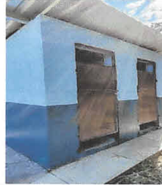
Foto 2: Restauracion de servicios sanitarios.
