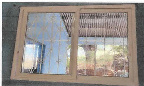
Foto 9: Restauración de balcones
